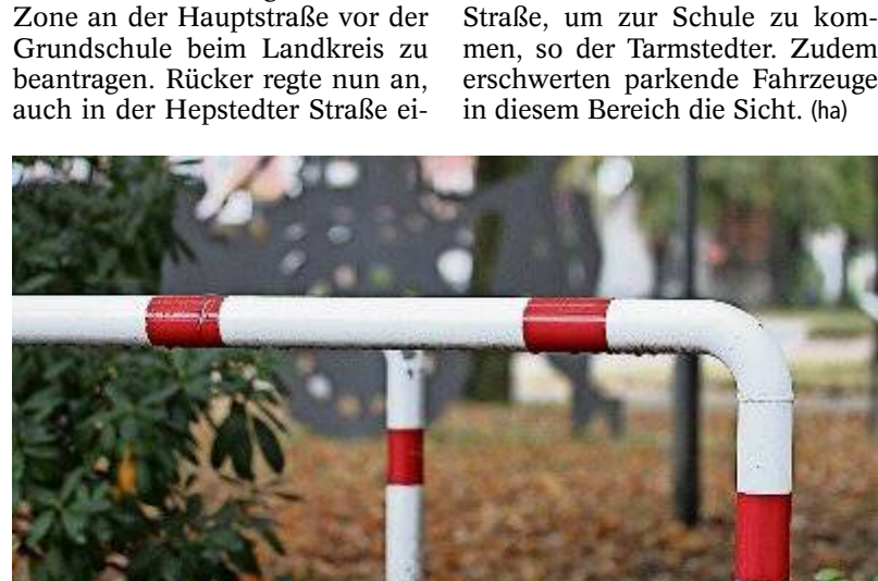
Am Fußweg entlang der Hauptstraße in Tarmstedt stehen bereits Metallbügel. Ähnliche wie diese zur Verkehrsberuhigung auch am Radweg neben dem Feuerwehrhaus aufzustellen, formulierte der Bau- und Wegeausschuss kürzlich in einer Empfehlung an den Gemeinderat.
